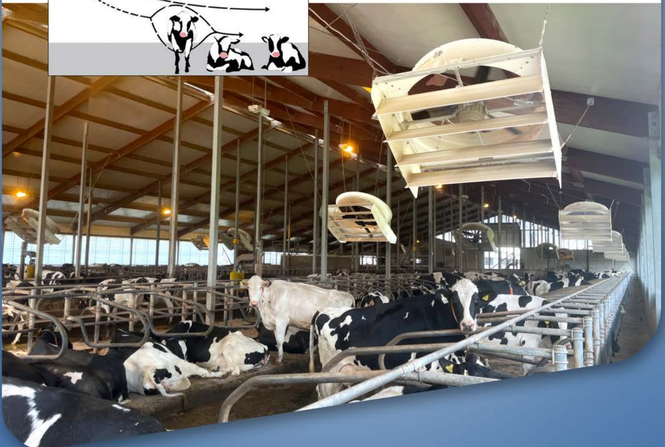
ECV ventilaatorid Väätša Agro piimafarmis
